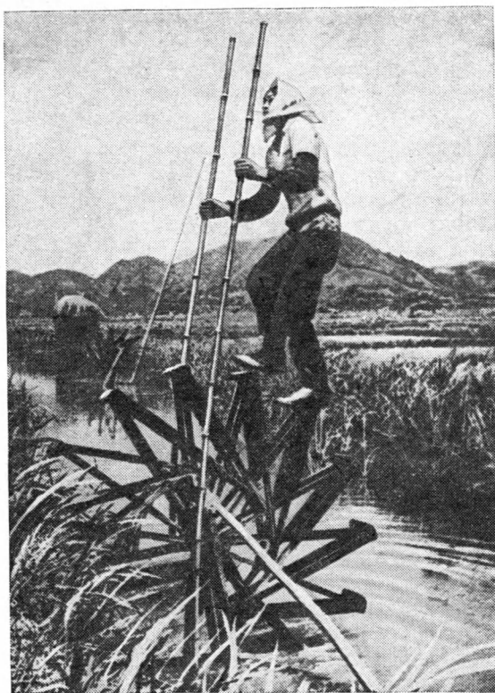
Рис. 4. Педальное водяное колесо (Япония).
